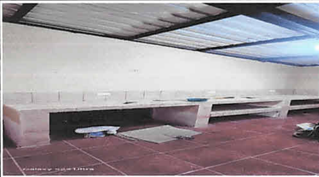
Sustitución de piso liso por piso cerámico.
